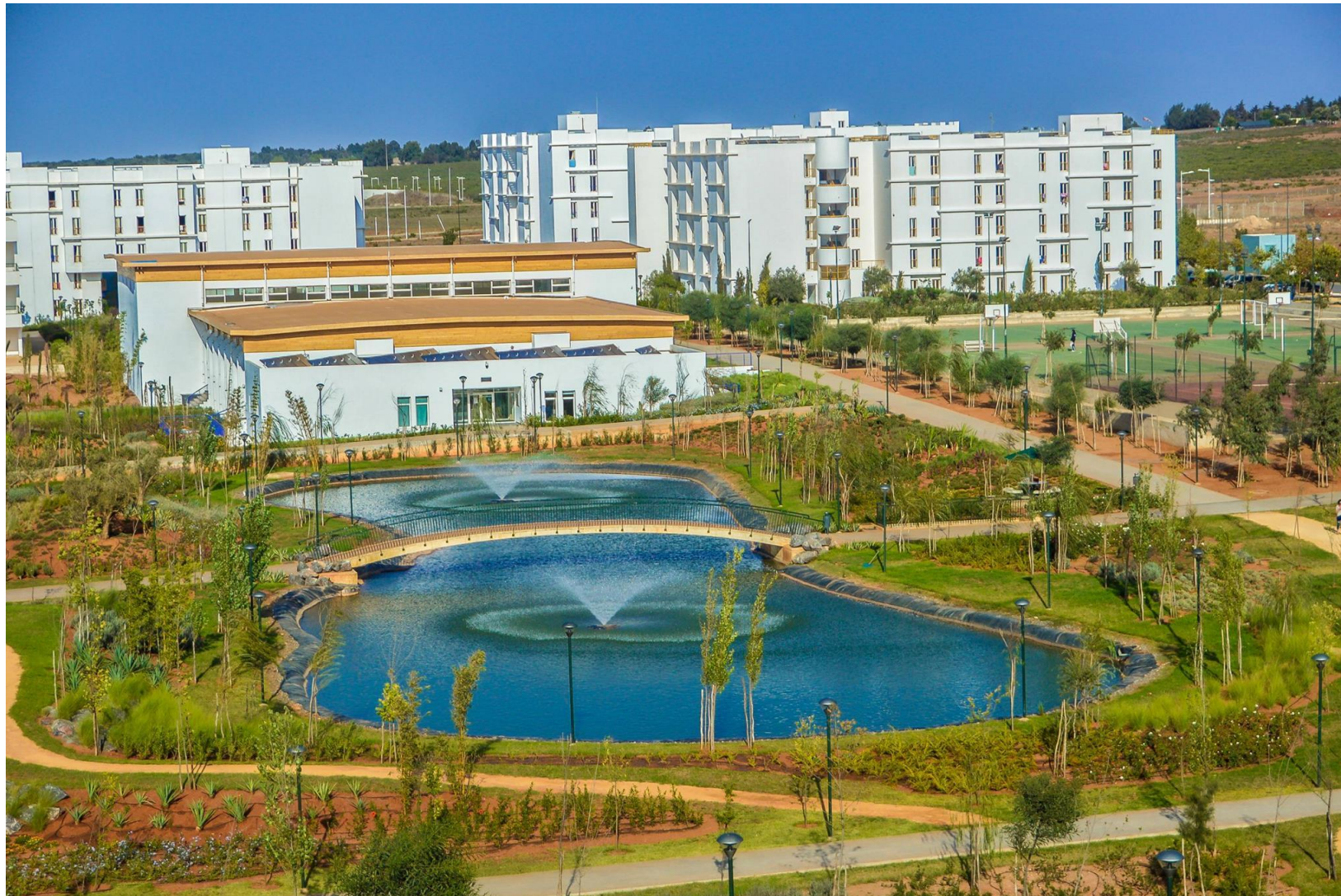
Bassin de rétention des eaux pluviales (2013).
