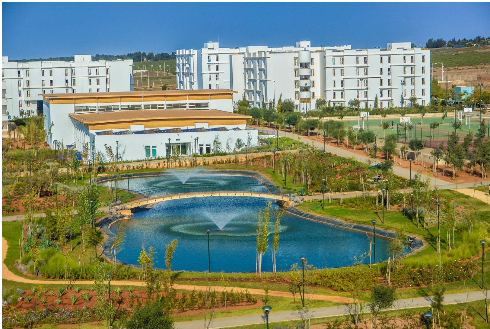
Bassin de rétention des eaux pluviales avec arrosage automatique (2013).
